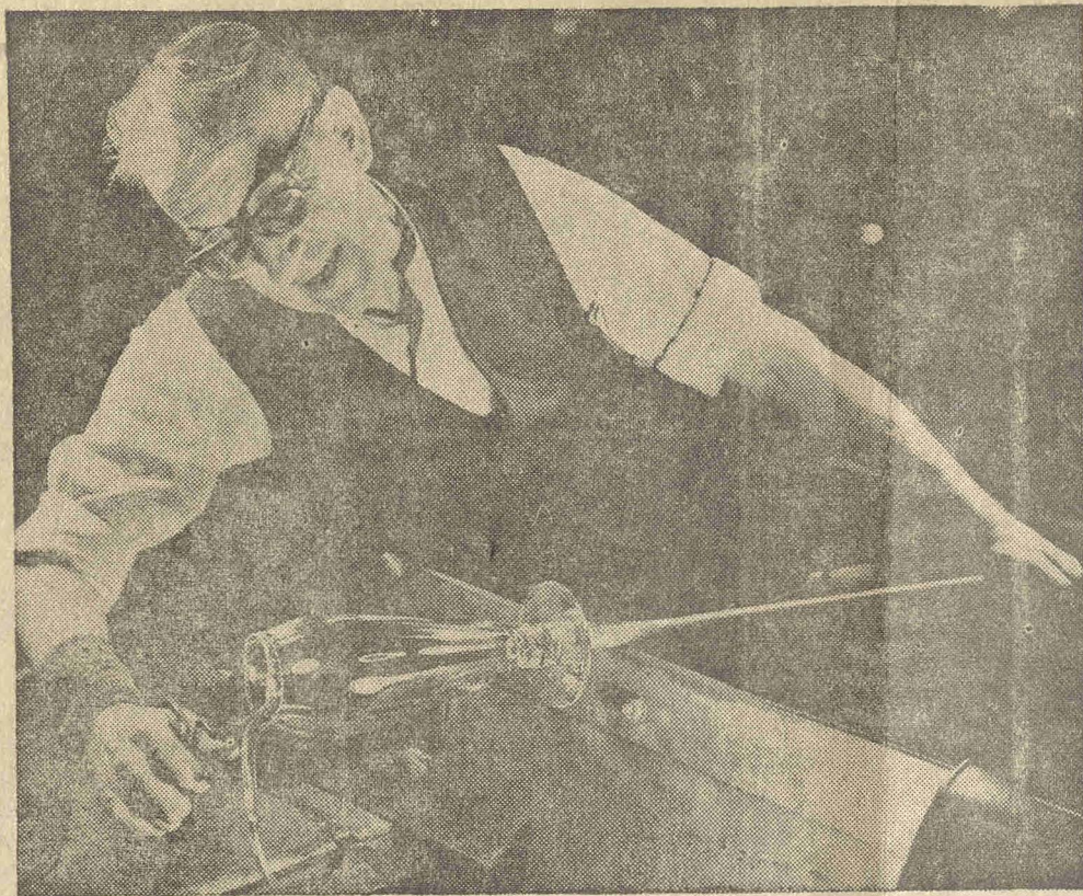
Ο έμπειρος αυτός τεχνίτης κόβει με ψαλλίδι ένα τεμάχιο φουσητής ύαλου άόμης ζεστής και ειδικάπτου. Μία σειρά προϊόντων της βιομηχανίας Ουέμπ Κόρμπετ Λτδ., εις την όποιαν εργάζεται, έλαβε τό βραβείον κομψότητας 4964 του Δ. Έδιμβούργου
