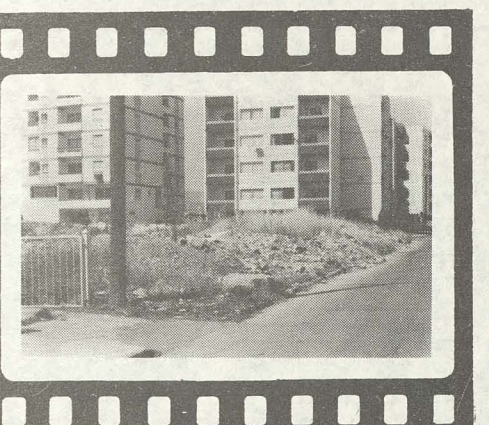
Μπροστά από τα θεώρατα κτίρια βουνά οι ακαθαρσίες στη Τουριστική περιοχή (οδός Τιμάρια) στη Νεάπολη.
