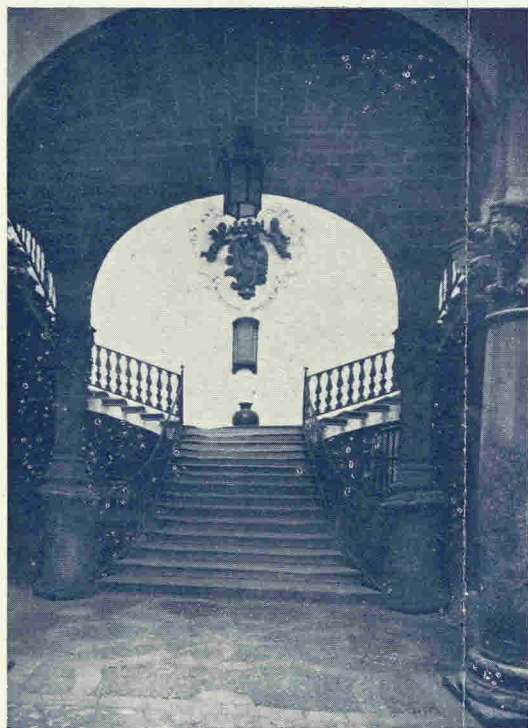
Escalera del patio del palacio de los Marqueses de Vivot
